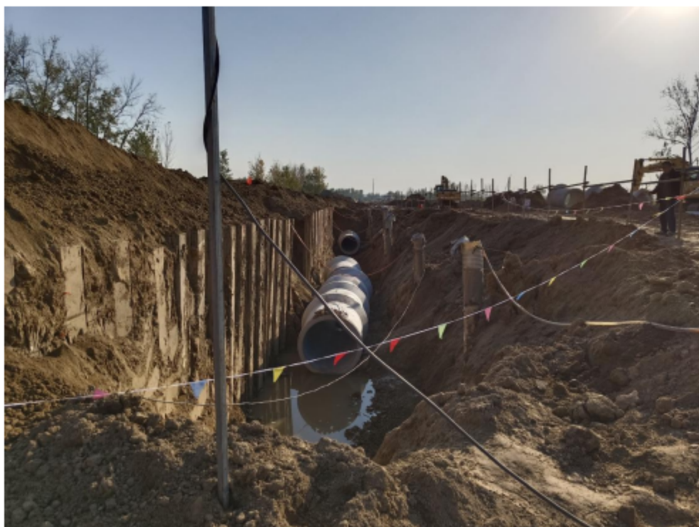
图 1 基坑整体情况（自北向南拍摄）
